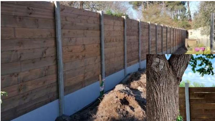
**Clôture béton remplissage bois**
